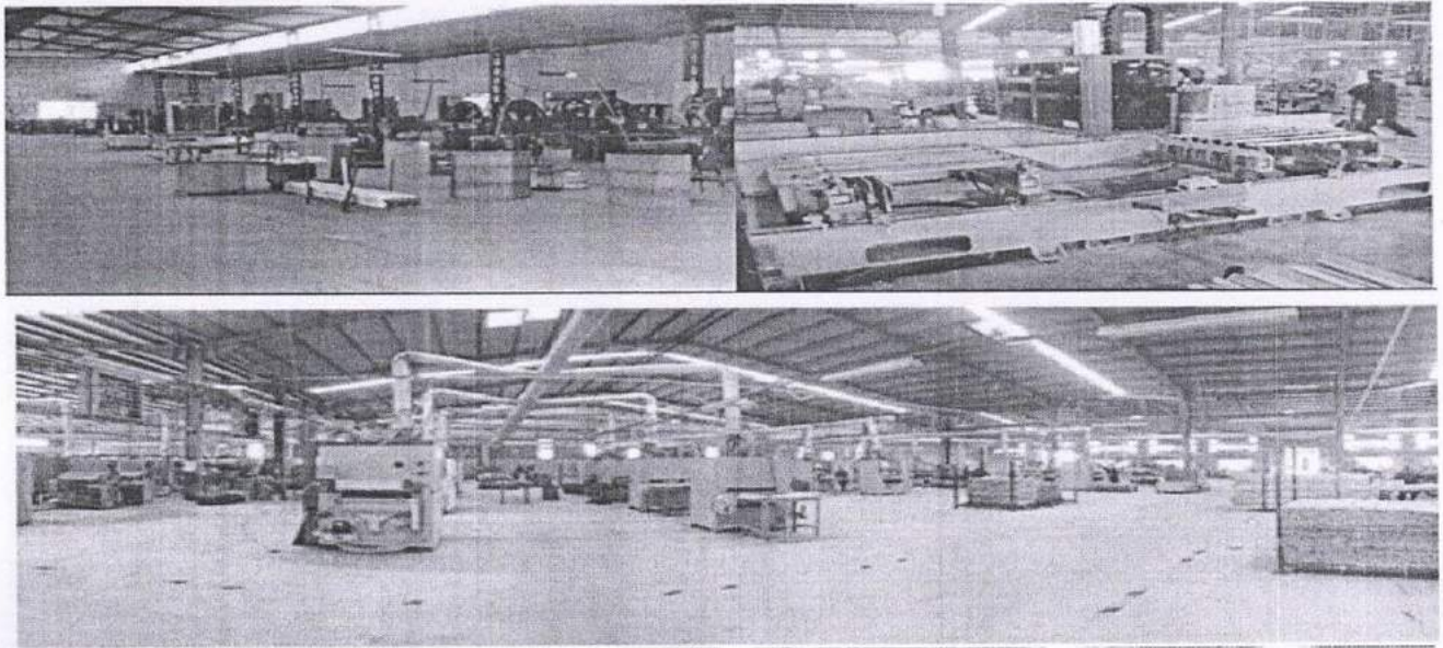
Nhà máy sản xuất
